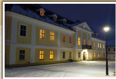
Domov Na zámku Kyjovice Kyjovice 1 747 68 Kyjovice
