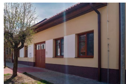
Dům postavený v Golčově Jeníkově zapadnul mezi okolní stavby, jako by tam stál odjakživa.
